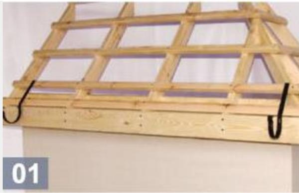
1. Определите места установки крайних держателей желобов с учетом того, что уклон желоба в направлении ливнеприемника должен составлять 3-5 мм на 1 погонный метр. Смонтируйте крайние держатели и разметьте между ними линию для установки остальных держателей.
