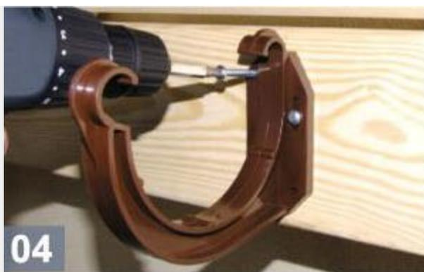
**4.** Фиксация третьим саморезом производится после монтажа всех держателей.
