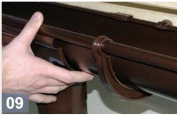
**9.** Левый (007L) и Правый (007L) ливнеприемники следует монтировать подобно Проходному ливнеприемнику (007) предусматривая, чтобы защелки ливнеприемника прилегали к держателю желоба.
