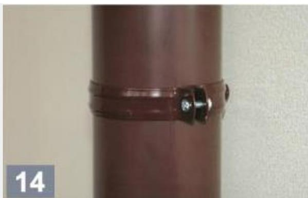
**14.** Монтаж водосточной трубы к стене осуществляется при помощи **Держателей трубы (019А/В/С)**. Длина держателей подбирается с учетом толщины теплоизоляции стен. При высоте здания до 10 метров держатели следует монтировать на расстоянии 2 метра друг от друга. При высоте более 10 метров - расстояние 1,5 метра. Для отвода дождевой воды на отмостку следует использовать колено трубы.
