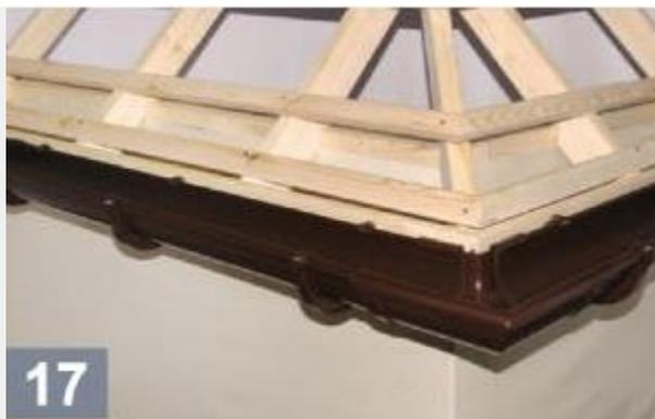
**17.** После проведения монтажа рекомендуется провести визуальный осмотр системы, с точки зрения того, как сделаны уклоны отвода воды.
